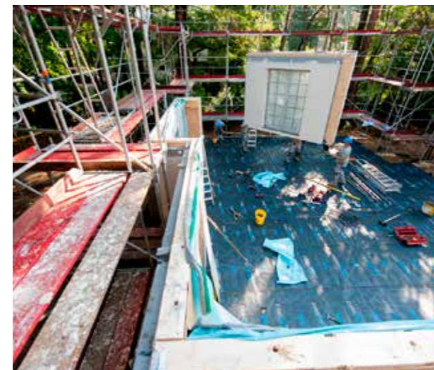
...und das Erdgeschoss auf das Fundament montiert.
