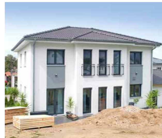
Nach ca. 12 Wochen ist die Villa fertig...
