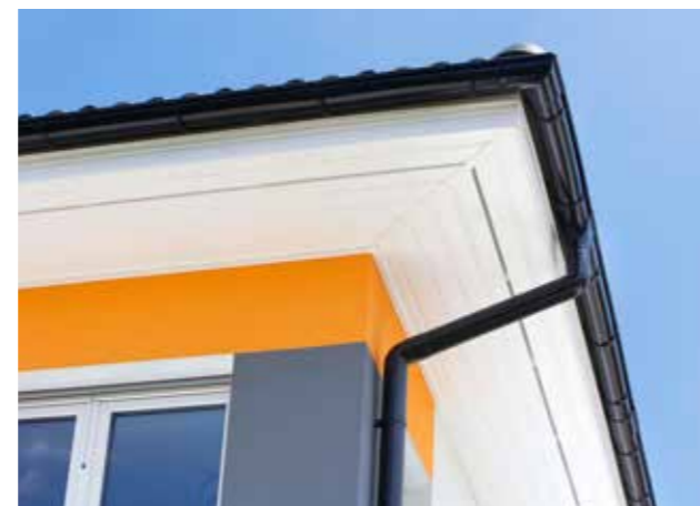
Die Unterseite des Dachüberstandes kann farbig (Sonderausstattung) oder in weiß (Standard) ausgeführt werden.
