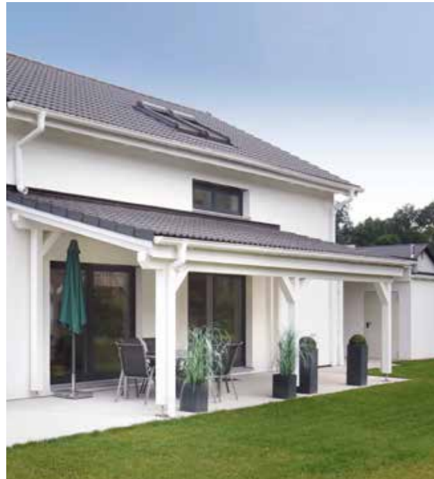
Solides Dach über der Terrasse
