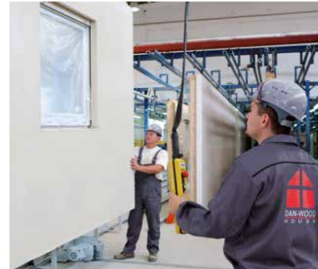
Die Wände werden in der Fabrik vorgefertigt...
