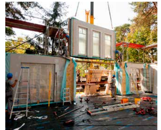
Anschließend wird das Obergeschoss aufgesetzt.
