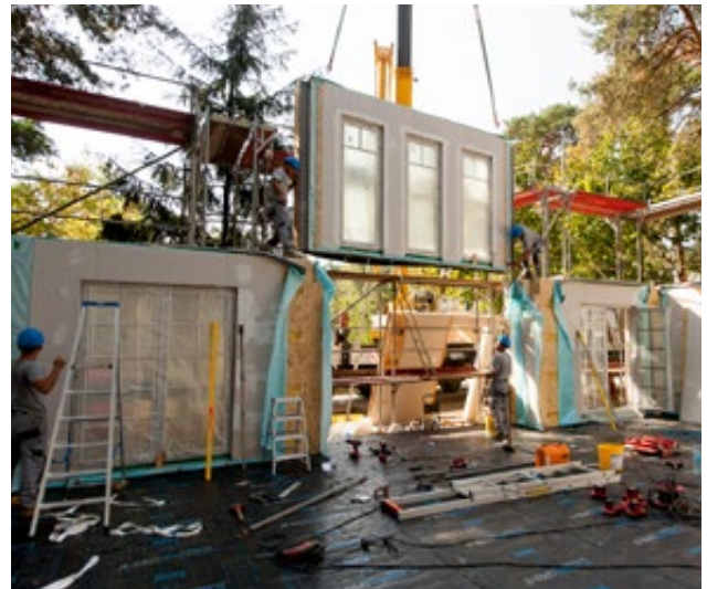
Anschließend wird das Obergeschoss aufgesetzt.
