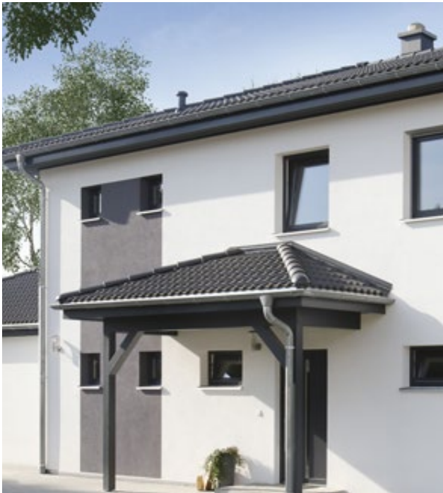
Auf eleganten Säulen ruht das ebenfalls großzügige Walm-Vordach.
