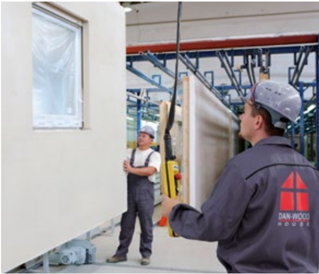
Die Wände werden in der Fabrik vorgefertigt...
