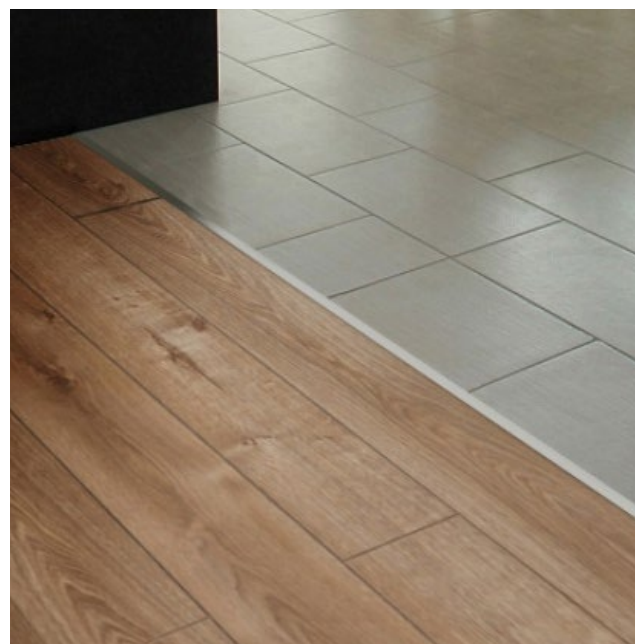
Übergänge zwischen zwei verschiedenen Bodenbelägen werden mit einer Fußbodenleiste kaschiert.
