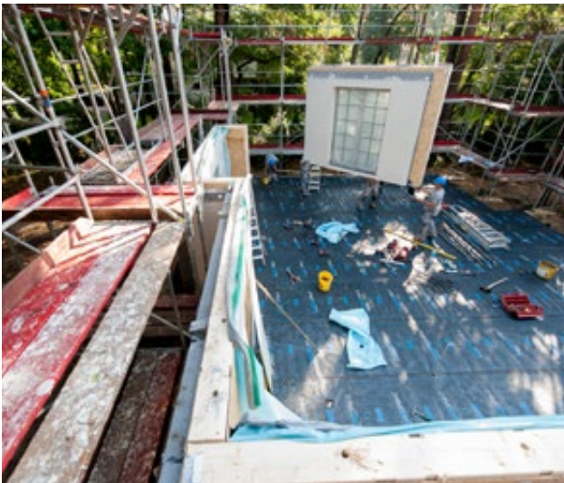
...und das Erdgeschoss auf das Fundament montiert.
