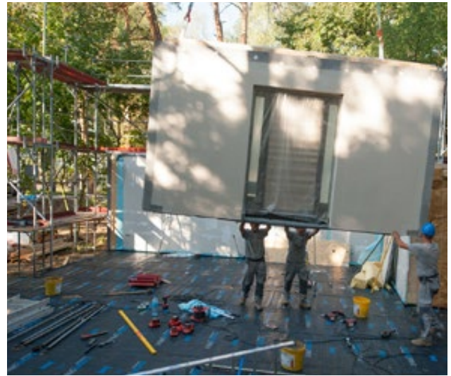
... auf LKW zum Bauplatz transportiert...
