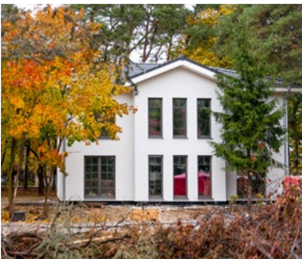
Nach ca. 12 Wochen ist die Villa fertig...
