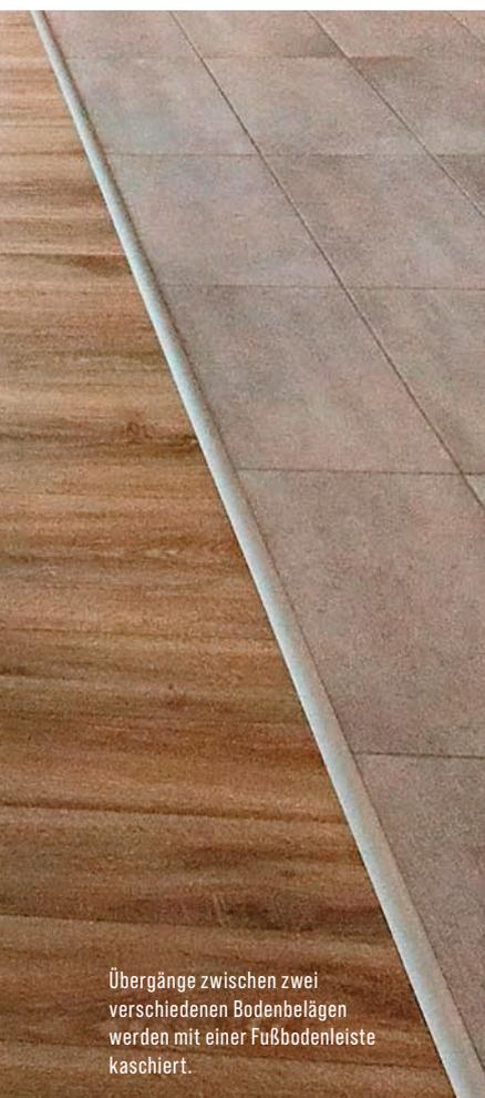
Übergänge zwischen zwei verschiedenen Bodenbelägen werden mit einer Fußbodenleiste kaschiert.
