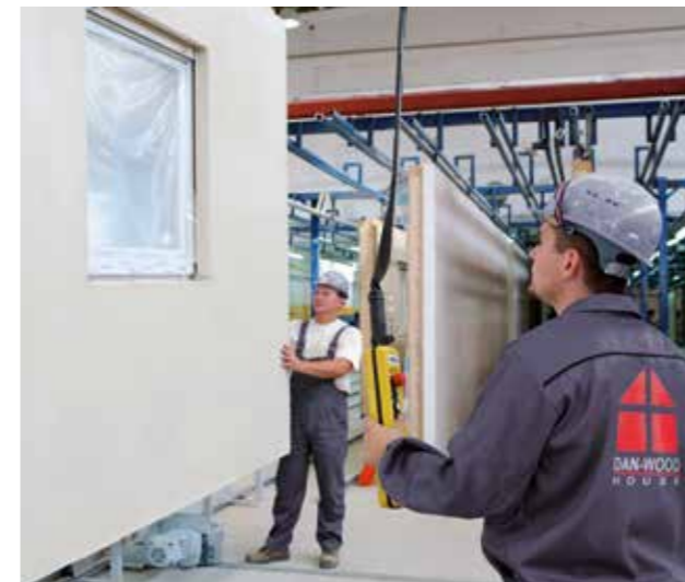
Die Wände werden in der Fabrik vorgefertigt...
