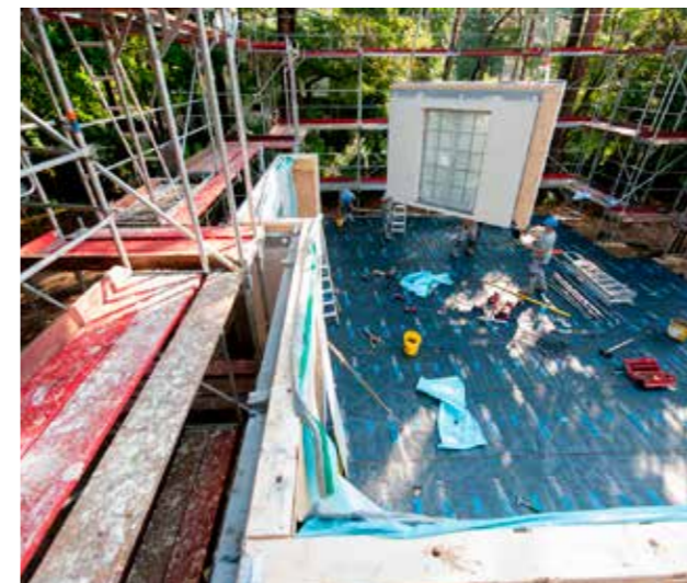
...und das Erdgeschoss auf das Fundament montiert.
