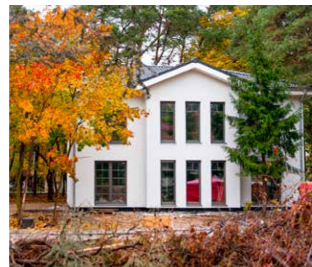
Nach ca. 12 Wochen ist die Villa fertig...
