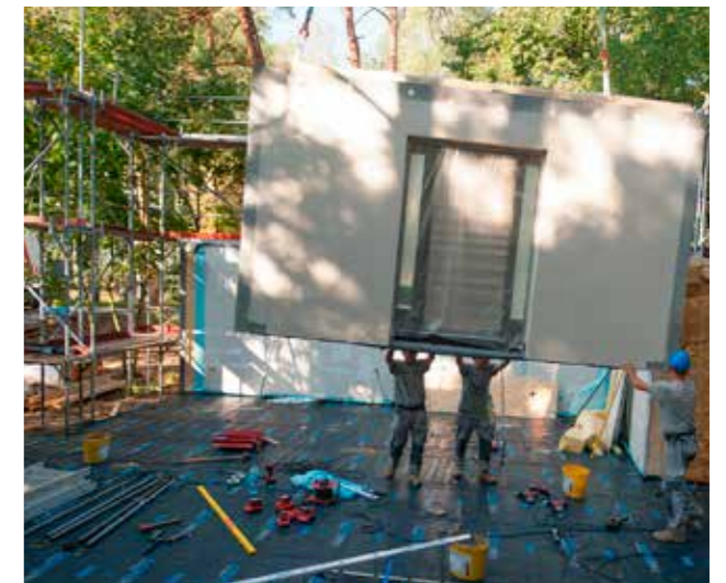
... auf LKW zum Bauplatz transportiert...
