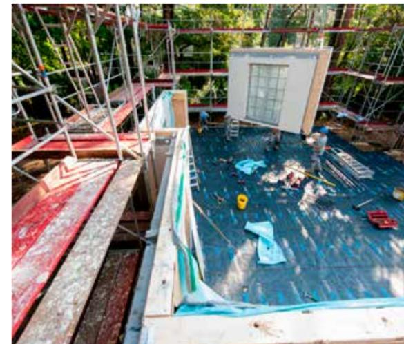
...und das Erdgeschoss auf das Fundament montiert.
