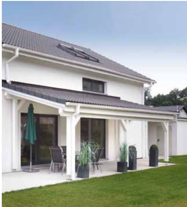
Solides Dach über der Terrasse
