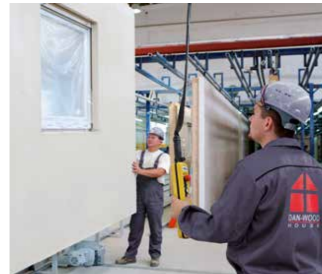
Die Wände werden in der Fabrik vorgefertigt...
