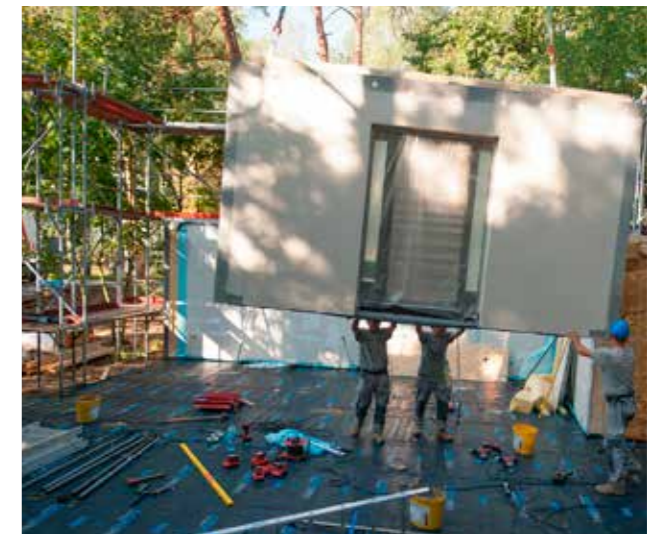
... auf LKW zum Bauplatz transportiert...
