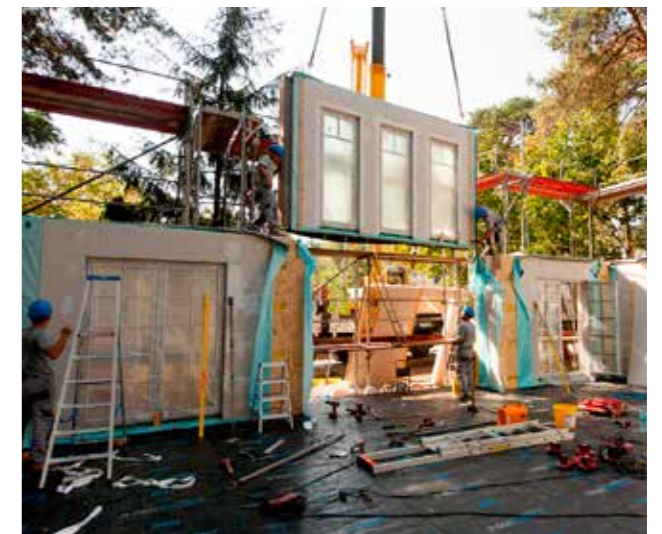
Anschließend wird das Obergeschoss aufgesetzt.
