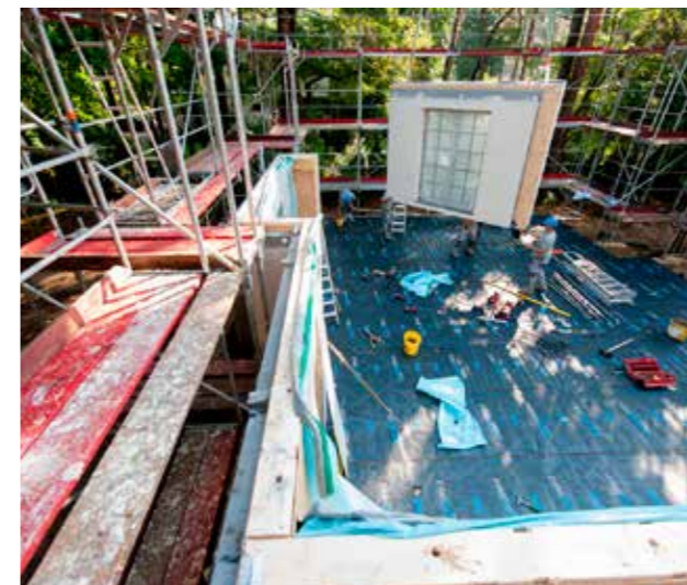
...und das Erdgeschoss auf das Fundament montiert.
