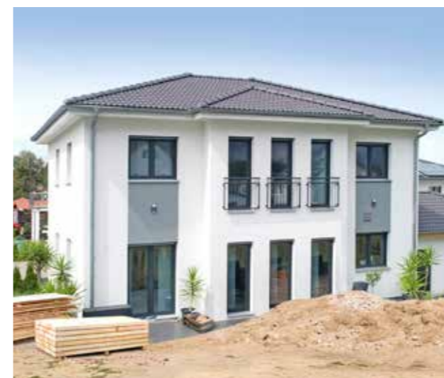
Nach ca. 12 Wochen ist die Villa fertig...
