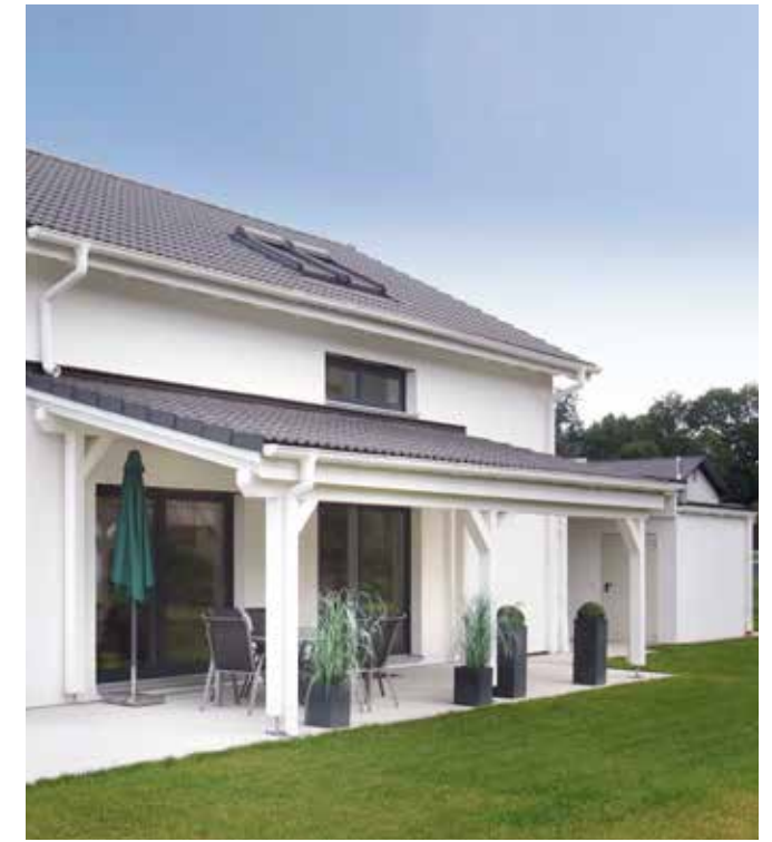
Solides Dach über der Terrasse
