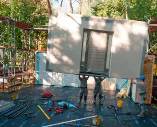
... auf LKW zum Bauplatz transportiert...
