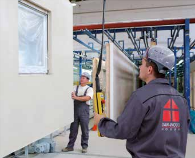
Die Wände werden in der Fabrik vorgefertigt...
