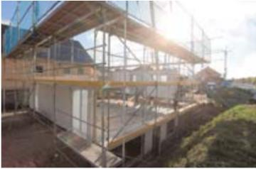
**1. Der Keller ist fertig und das Gerüst steht:** Am 2. Mai morgens um 7:20 werden mit den ersten Sonnenstrahlen die ersten Fertigwände in Überlingen am Ried eingesetzt. Noch unvorstellbar, in nur zwei Tagen soll hier ein fertiges Einfamilienhaus entstehen.
